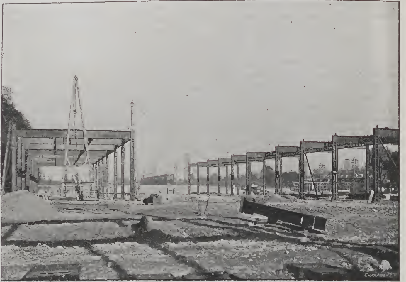
LES CHANTIERS DES INVALIDES. — Commencement du montage des palais.
